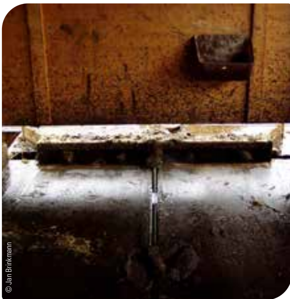
Abb. 62: Entmistungsschieber im Ruhezustand außerhalb des Tierbereichs
